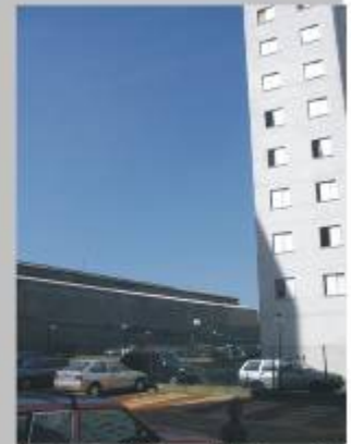
Foto 94: área de estacionamento
