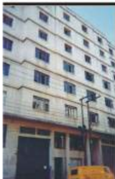
Foto 128: prédio antes da reforma Fonte: DÉBORA SANCHES, 2004
