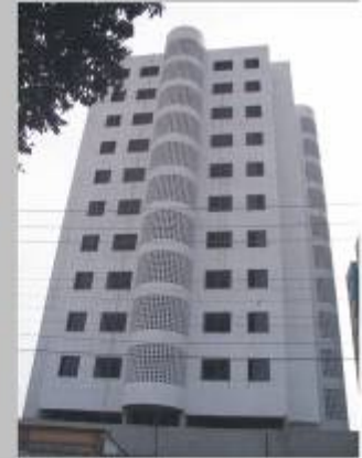
Foto 76: obras dos edifícios A e C Fonte: DÉBORA SANCHES, 2007
