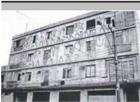
Foto 59: imóvel antes da obra Fonte: RELATÓRIO FINAL DA COMISSÃO DE ESTUDOS SOBRE HABITAÇÃO NA ÁREA CENTRAL PMSP/CMSP, 2001
