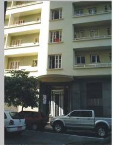
Foto 70: acesso principal Fonte: DÉBORA SANCHES, 2008
