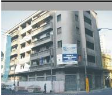
Foto 107: obras em 2001 Fonte: CURY, 2008
