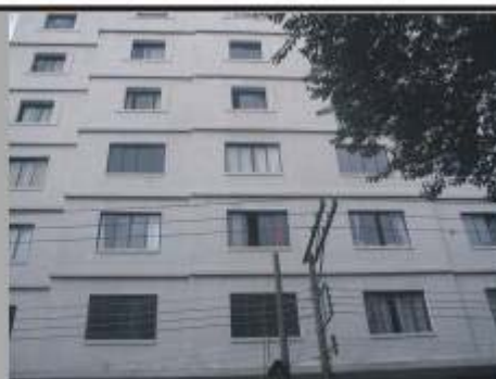
Foto 129: prédio depois da reforma Fonte: DÉBORA SANCHES, 2007
