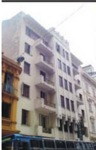
Foto 147: : Fachada principal Fonte: COHAB, 2006
