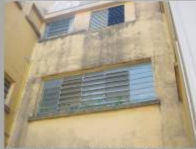
Foto 111: poço de iluminação Fonte: AÉCIO LACERDA, 2007
