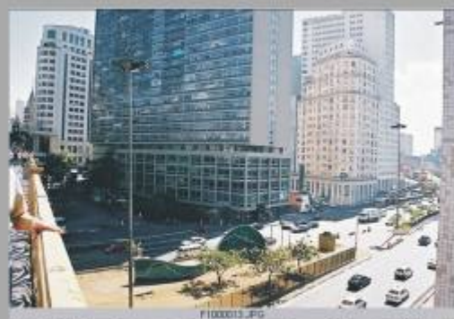
Foto 115: inserção urbana do prédio no Vale do Anhangabaú
