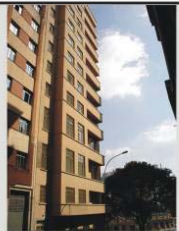
Foto 146: Fachada principal Fonte: COHAB, 2008
