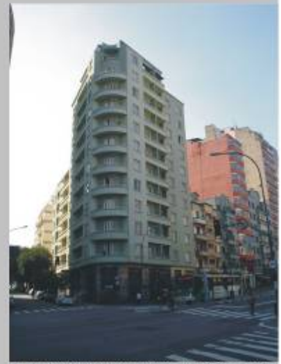
Foto 67: vista do prédio Av. São João x Rua Ana Cintra Fonte: DÉBORA SANCHES, 2008
