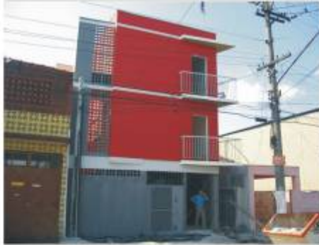
Foto 44: fachada no final das obras Fonte: DÉBORASANCHES, 2004
