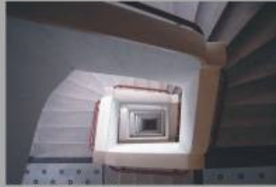
Foto 120: detalhe da escada Fonte: JULIANO BUSTAMANTE, 2007
