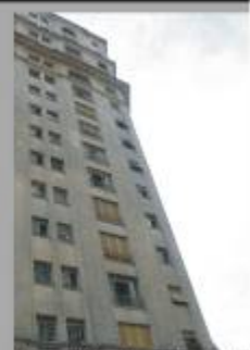
Foto 118: detalhe da fachada lateral Fonte: JULIANO BUSTAMANTE, 2007
