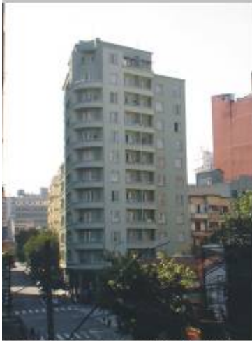
Foto 68: vista do prédio Av. São João Fonte: DÉBORA SANCHES, 2008
