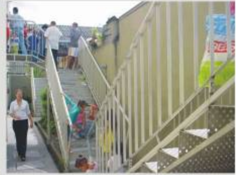
Foto 46: escadas de acesso Fonte: AÉCIO LACERDA, 2007
