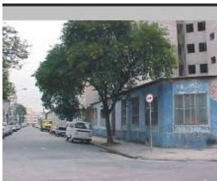
Foto 77: período em construção e as fachadas remanescentes dos lotes que haviam no terreno. Fonte: CDHU, 2004
